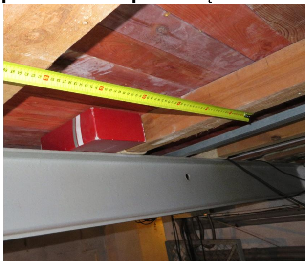
Strop nad piwnicami -konstrukcja podporowa stalowa pod sceną
