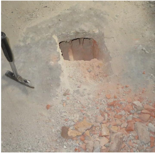
-odkrywka stropu nad rekwizytornią
