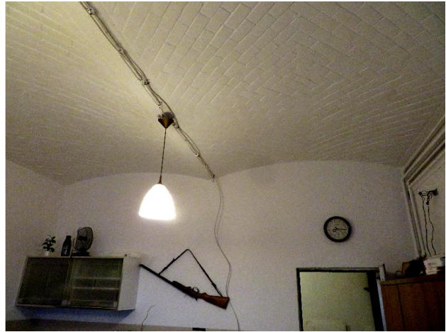
Strop nad parterem masywny sklepieniowy ceramiczno- stalowy
