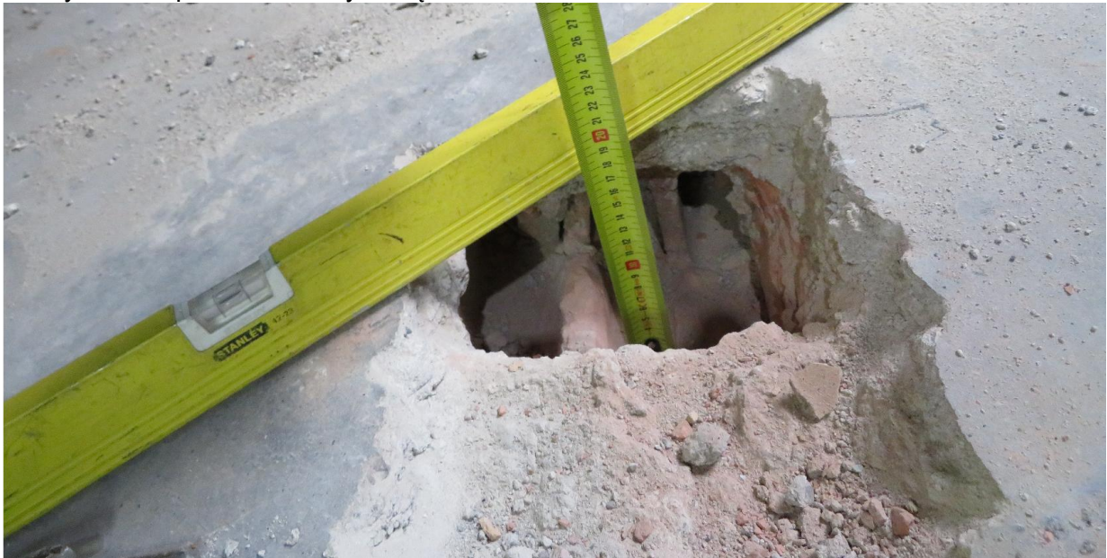
-odkrywka stropu nad rekwizytornią
