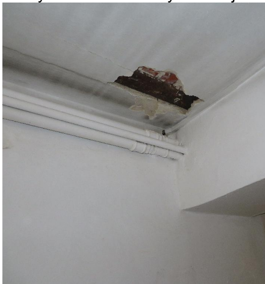
Strop nad I piętrem stalowo ceramiczny Kleina i stalowo-betonowy Odkrywką w części korytarzowej -strop Kleina odmiany ciężkiej
