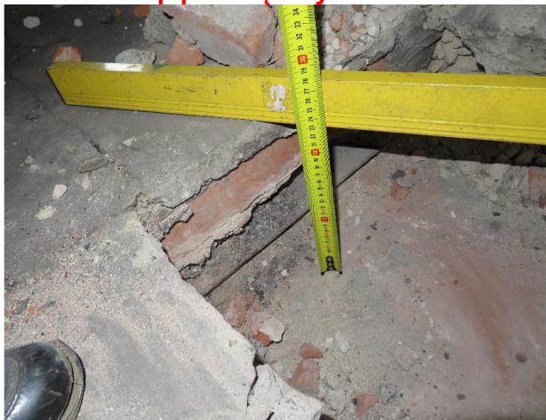
Strop Kleina nad II piętnem nad pomieszczeniem do prób -odkrywki-stwierdzono kształtownik 180mm - strop przeciążony
