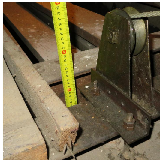
Strop nad piwnicami -konstrukcja podporowa stalowa pod sceną
