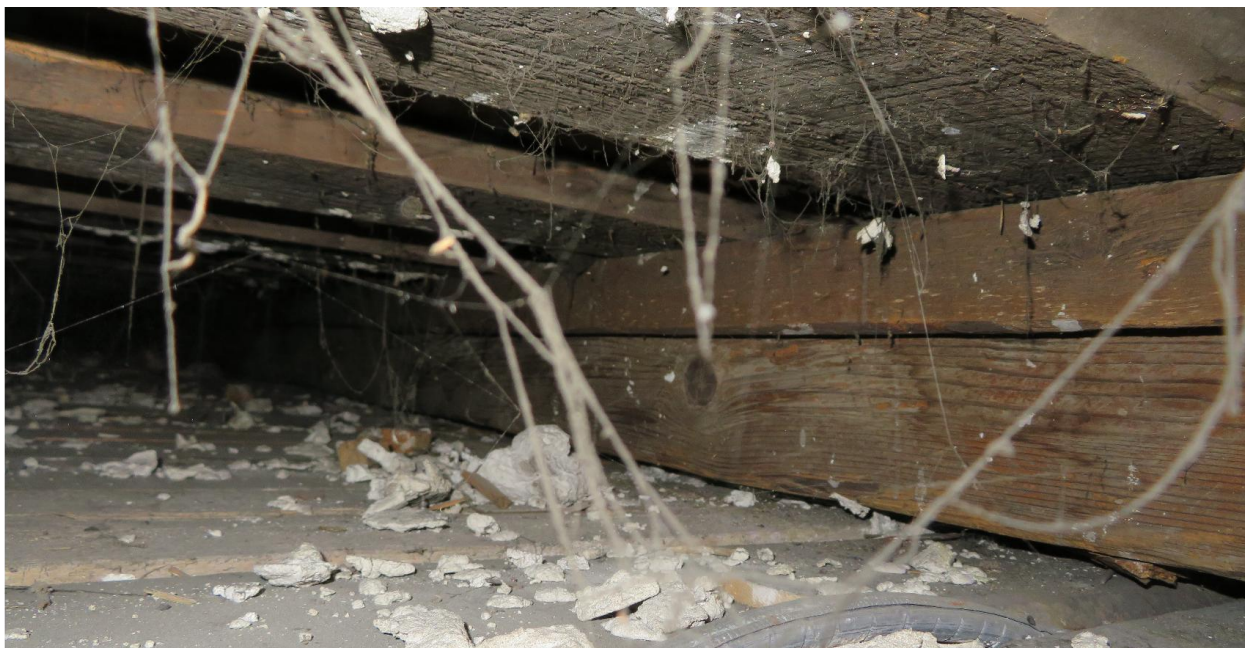
Strop Kleina nad II piętnem nad pomieszczeniem do prób -odkrywki-stwierdzono kształtownik 180mm - strop przeciążony
