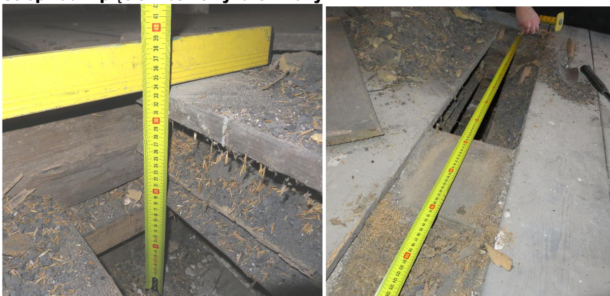
Strop belkowy -odkrywki -zdjęcie poniżej -widok przestrzeni pod podłogowej -pod ślepym pułapem -stan techniczny elementów drewnianych zadowalający
