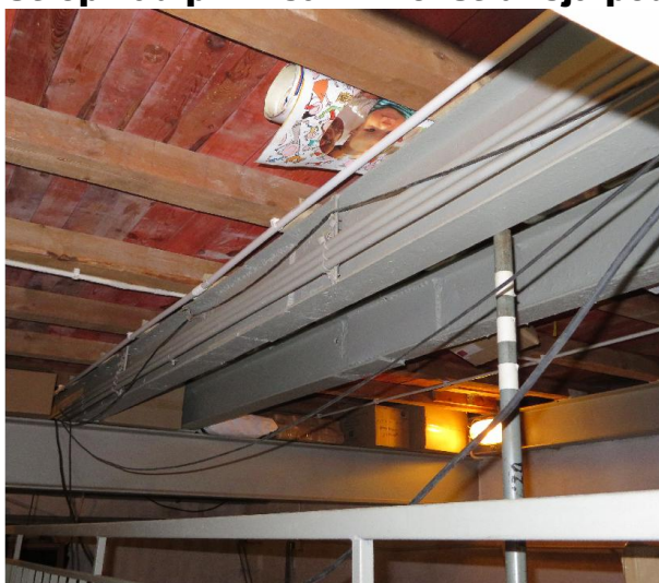
Strop nad piwnicami -konstrukcja podporowa stalowa pod sceną
