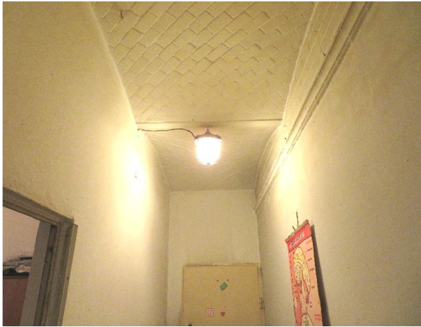
Strop nad parterem masywny sklepieniowy ceramiczno- stalowy
