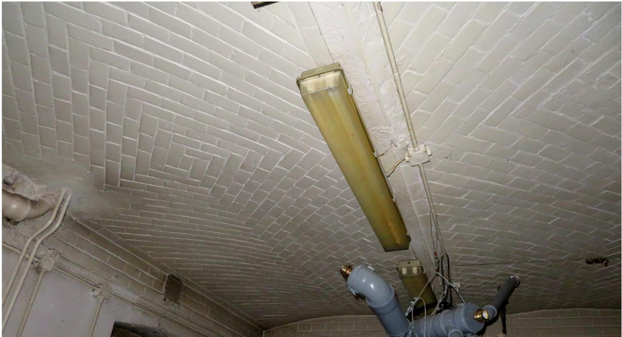
Strop nad parterem masywny sklepieniowy ceramiczno- stalowy
