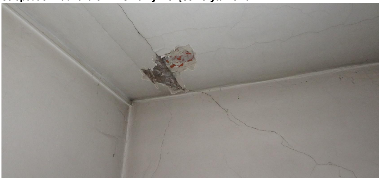
Budynek mieszkalny strop nad III piętrem systemu Kleina Stropodach nad lokalem mieszkalnym-część korytarzowa
