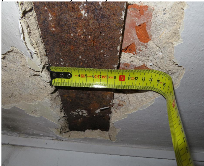
Strop nad I piętrem stalowo ceramiczny Kleina i stalowo-betonowy Odkrywką w części korytarzowej -strop Kleina odmiany ciężkiej
