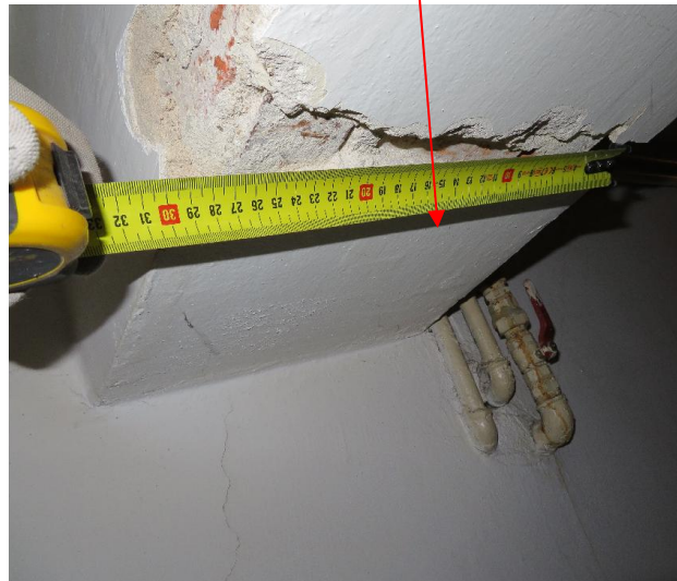
Strop nad I piętrem stalowo ceramiczny Kleina i stalowo-betonowy Odkrywką w części korytarzowej -strop Kleina odmiany ciężkiej
