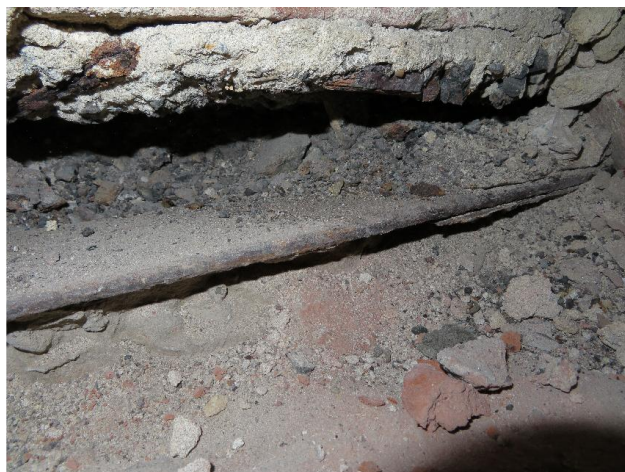
Strop Kleina nad II piętnem nad pomieszczeniem do prób -odkrywki-stwierdzono kształtownik 180mm - strop przeciążony
